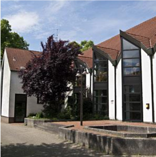
Abbildung 2: Gemeindezentrum Schlebusch, Südansicht
