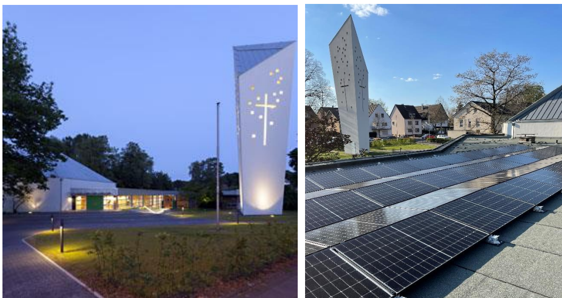
Abbildung 3: Friedenskirche und Gemeindezentrum Waldsiedlung mit beleuchtetem Glockenturm (links), Blick über die PV-Anlage zum Glockenturm (rechts)
